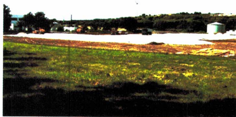
Derzeitiger Stand der Bauarbeiten im Entsorgungszentrum „Alte Schanze“.
